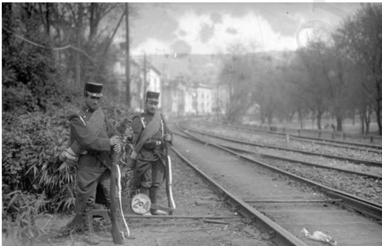
Soldados de Ingenieros en un cambio de vías, 1920
