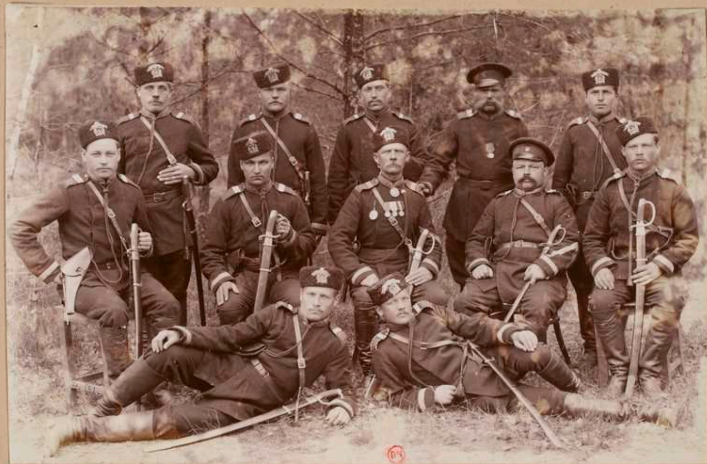
Officier de la 1 me Batterie de la 10 eme Brigade d'Artillerie à Lodz
