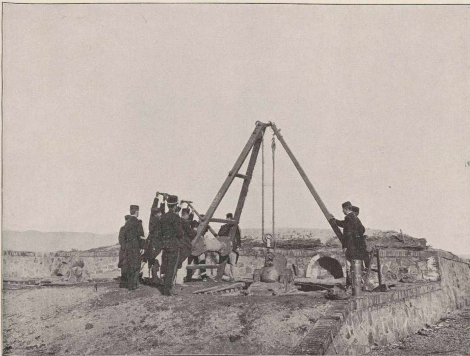
ESCUELA PRÁCTICA.—MANEJO DE CABRIAS.—Desmontando un mortero de 27 centímetros para la reparación de su explanada.
