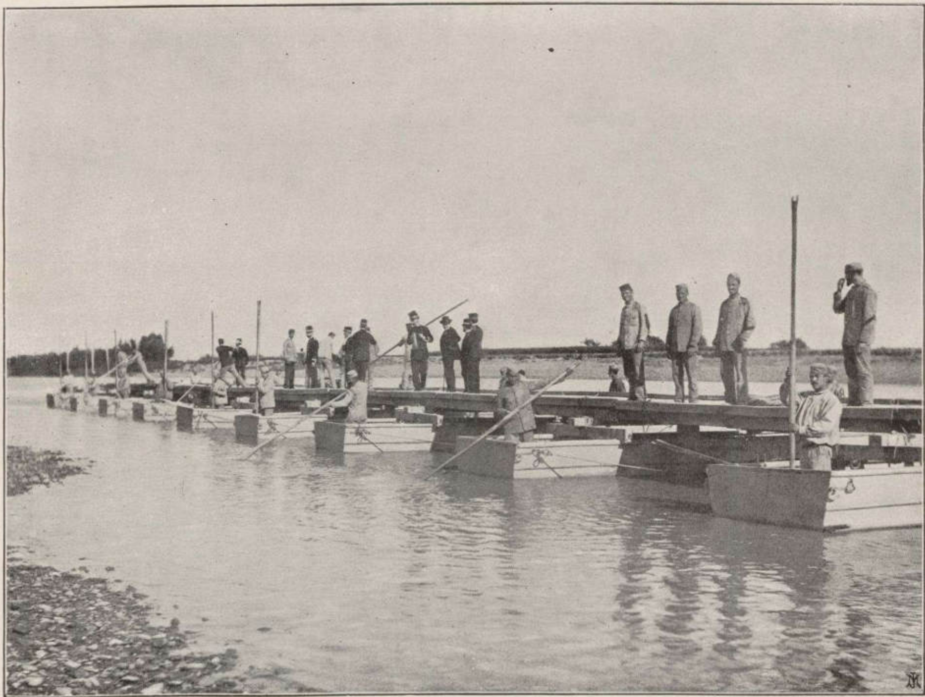
CONVERSIÓN. —Después de replegado el puente por conversión agua-abajo, medio rápido de interrumpir las comunicaciones, comienza el restablecimiento de ellas por el mismo método de conversión agua-arriba.
