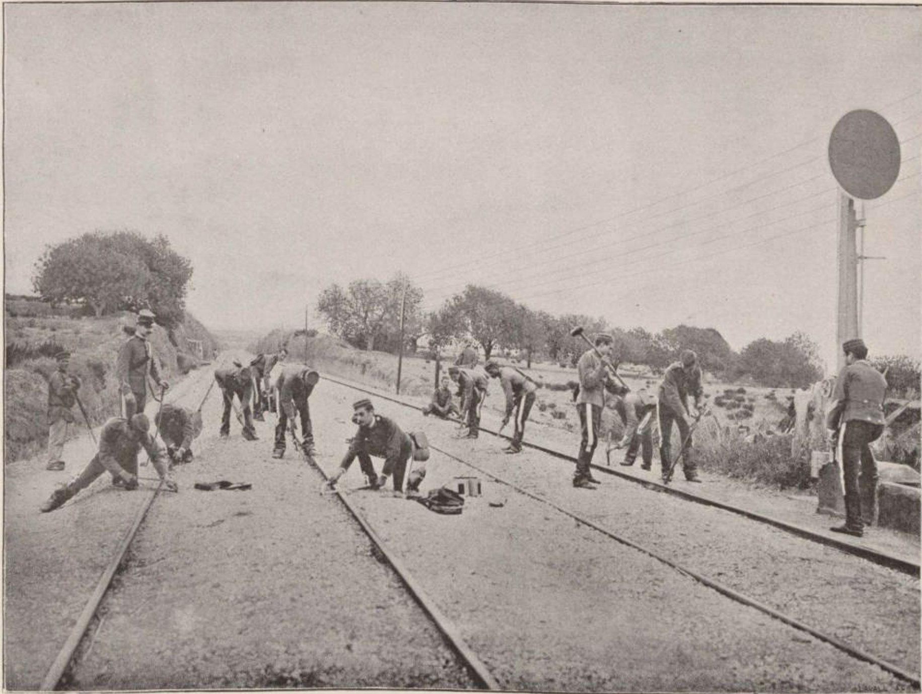
OBROS DESTROYENDO UNA VÍA FÉRREA. —Provistos de los instrumentos más indispensables y perfectos, una sección de obreros de uno de nuestros escuadrones de caballería procede á destruir los rails de una vía férrea para impedir el paso de trenes al enemigo, hecho lo cual montan otra vez para reunirse á la demás fuerza que espera á retaguardia.
