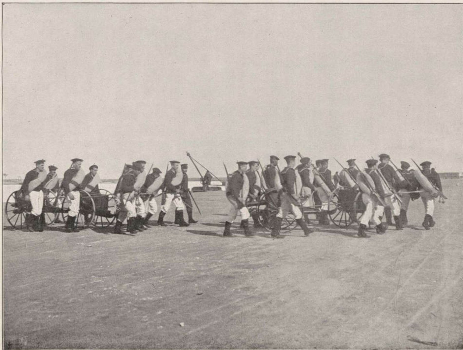
ARTILLERÍA DE DESEMBARCO. —Nuestro fotograbado representa un grupo que se ejercita en el manejo de dos piezas de desembarco. Éstas y los arzones son arrastradas por los artilleros, por medio de cables expofeso, y se transportan de este modo á los puntos donde conviene utilizarlas.
