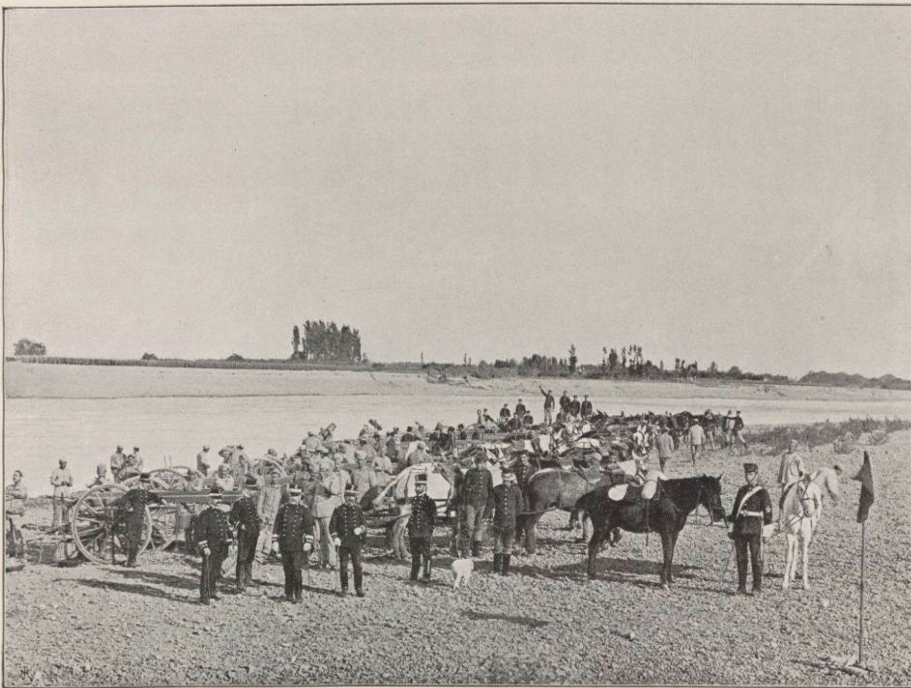
CARGA DEL MATERIAL. — Los carros de pontón suelen establecerse agua-arriba del puente, y los de caballete, tablones y reserva, agua-abajo. Estos son los representados después de construido el puente y estando en descanso la fuerza que no presta el servicio del puente.
