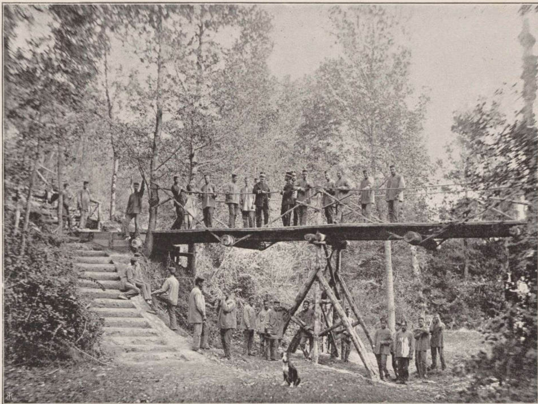
PUNTES MILITARES. —No puede darse puente más sencillo y sólido que el presente de caballetes con maderas rollizas y cuerdas, es decir, hecho con los elementos del terreno mismo.
