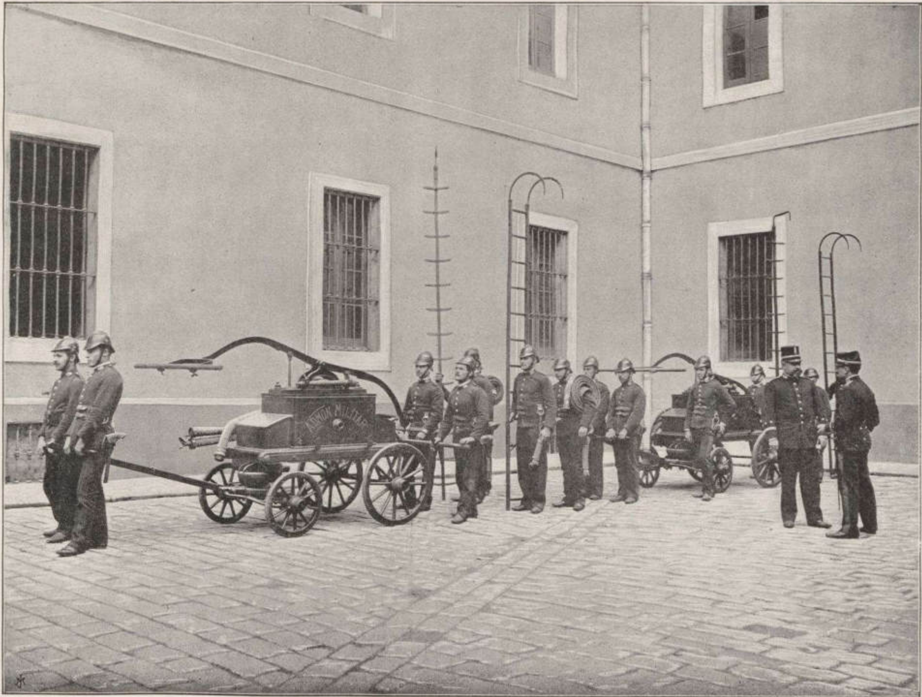
SERVICIO DE INCENDIOS. —Las factorías militares cuentan con un parque provisto de los útiles más modernos para la extinción de incendios. La presente autotipia, que reproduce el momento de la formación de la fuerza destinada á este servicio, da idea exacta de las bombas y demás aparatos existentes en una de esas factorías.
