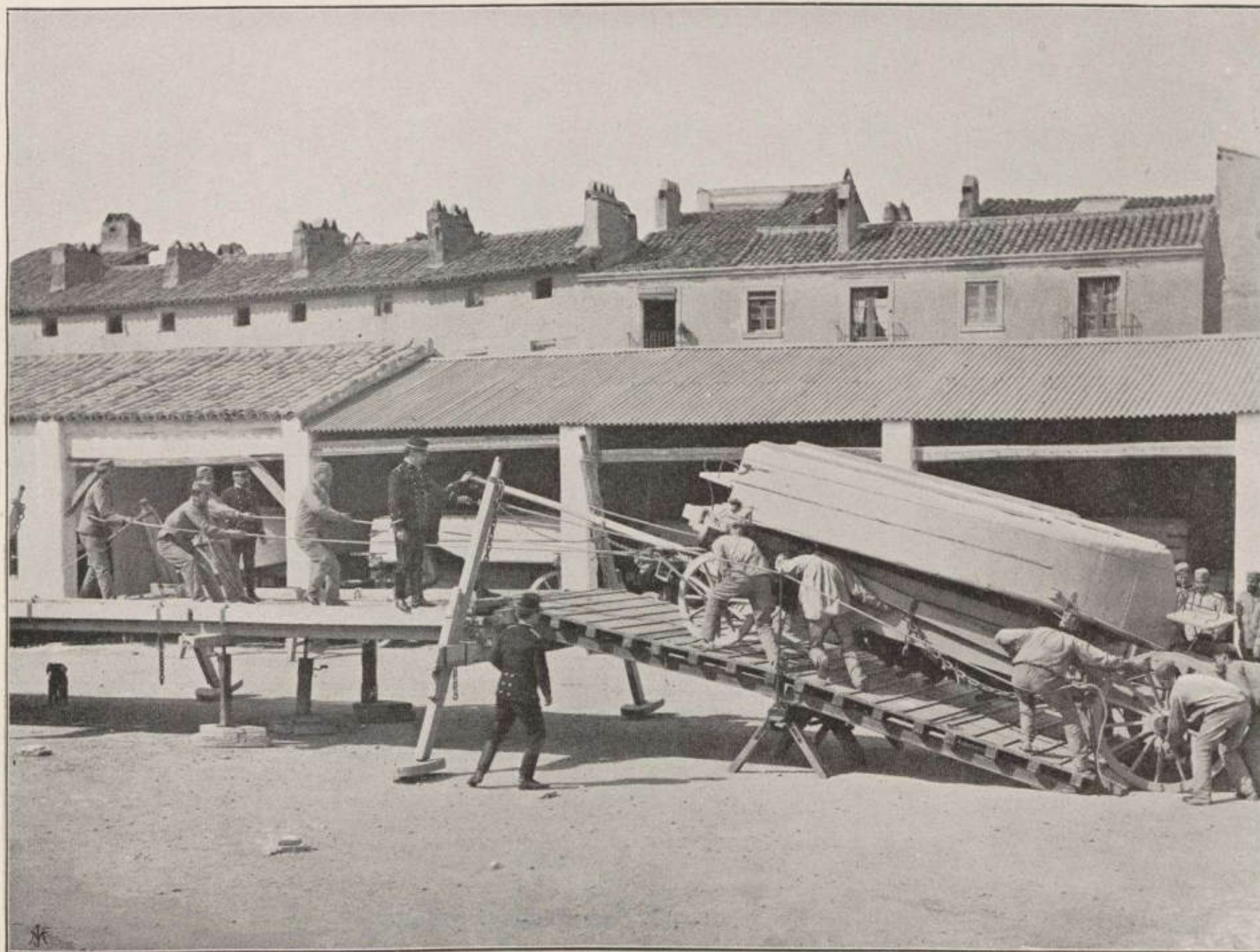
EMBARQUE EN FERROCARRIL. — En el patio del cuartel se ejercitan los pontoneros en el empleo de la rampa reglamentaria, sistema Peralta. Un tramo de puente de caballete sustituye la plataforma del ferrocarril. Se representa la carga, a la enfilada de un carro de viguetas, modelo Birago.
