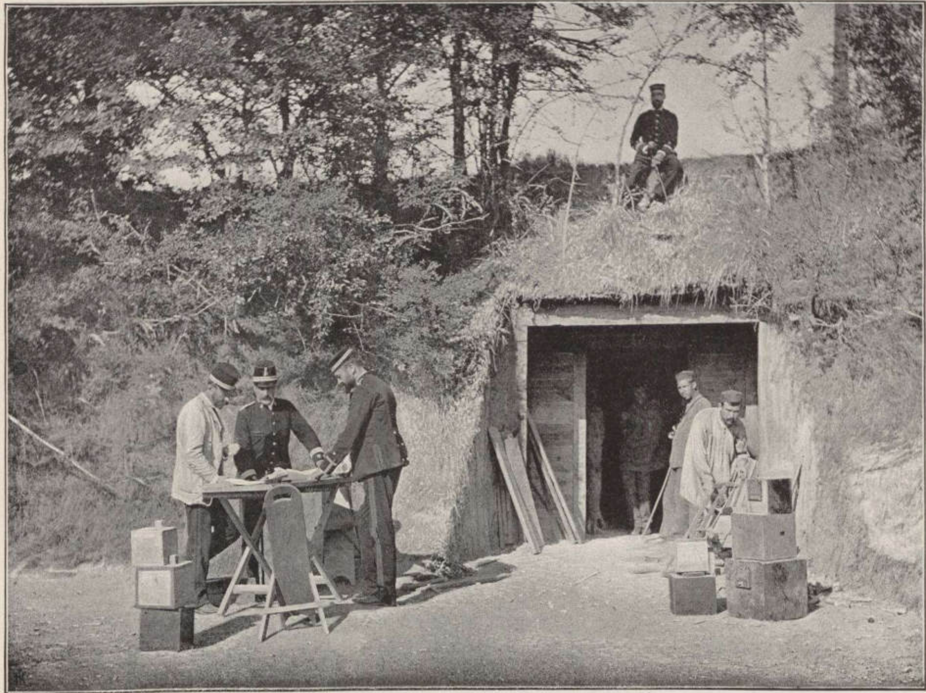
ESCUELA PRÁCTICA.—Construcción de galerías de minas para voladuras.
