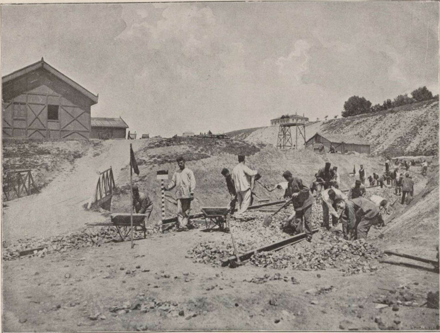
SENTANDO UNA VIA FÉRREA. —En otro de nuestros fotograbados, reproducimos los preliminares para sentar la vía, y en el presente,—cuya belleza artística no escapará á nuestros lectores,— se ve cómo queda rápidamente sentada, pues mientras unos obreros rectifican la medición, van otros colocando las traviesas que son inmediatamente cubiertas por los rieles.
