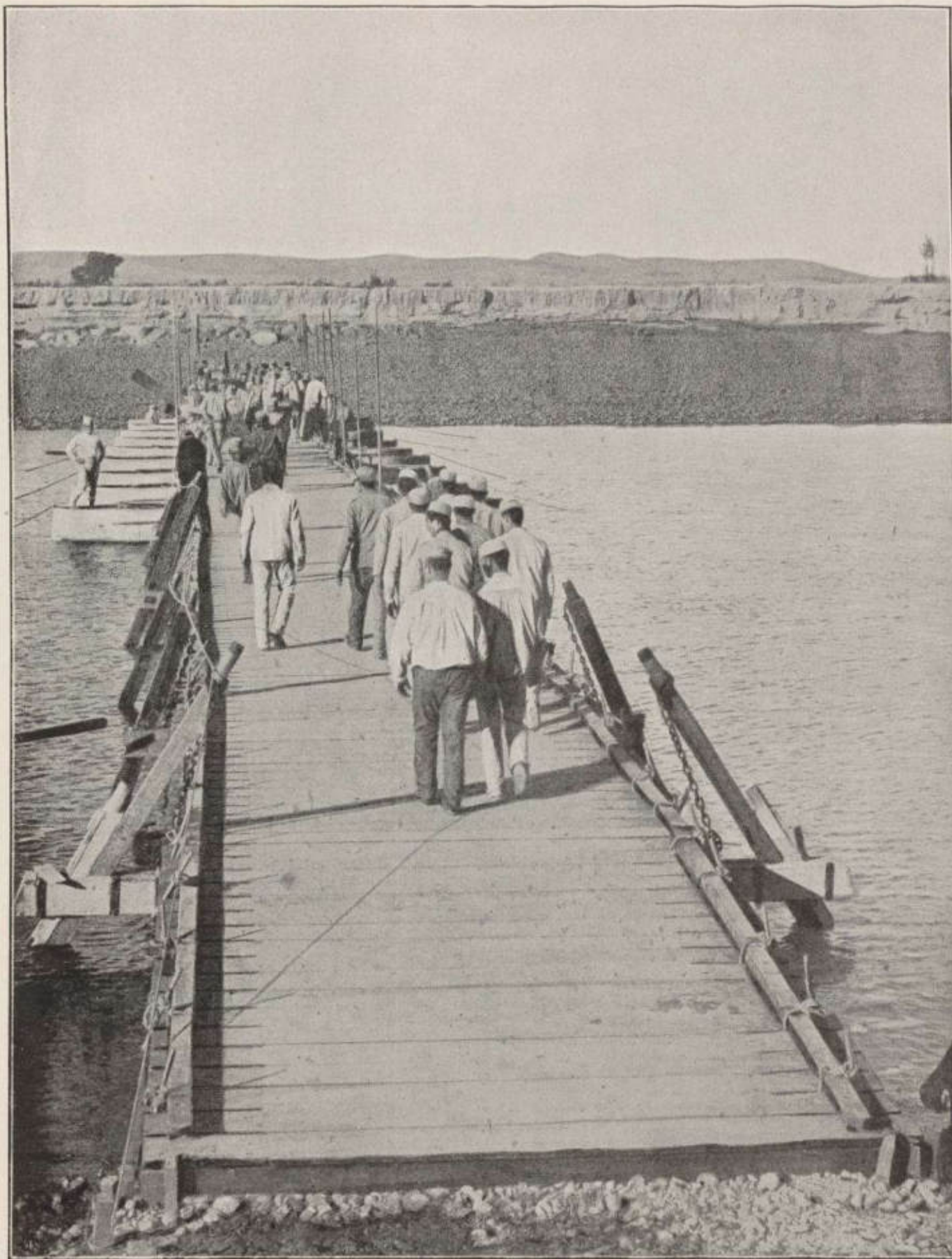
REPLIEGUE DEL PUENTE. —Comienza el repliegue de un puente tendido sobre el río Ebro en las cercanías de Zaragoza. Los porta-tablones retiran el material correspondiente, y la sección de porta-viguetas entra en el puente para replegar el suyo.
