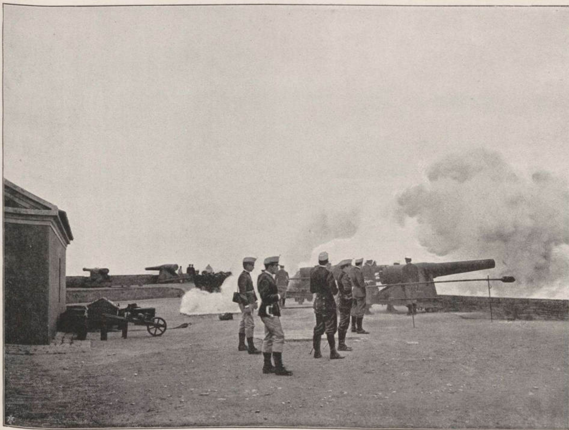
FORTALEZAS. —Batería de dos cañones de 15 centímetros, de hierro, rayados y sunchados, cuyo modelo, aunque no reglamentario, es de una precisión admirable, pues hemos tenido ocasión de apreciar que, á una distancia de 4 kilómetros y con un reducido número de disparos, ha sido tocado varias veces un pequeño blanco flotante.
