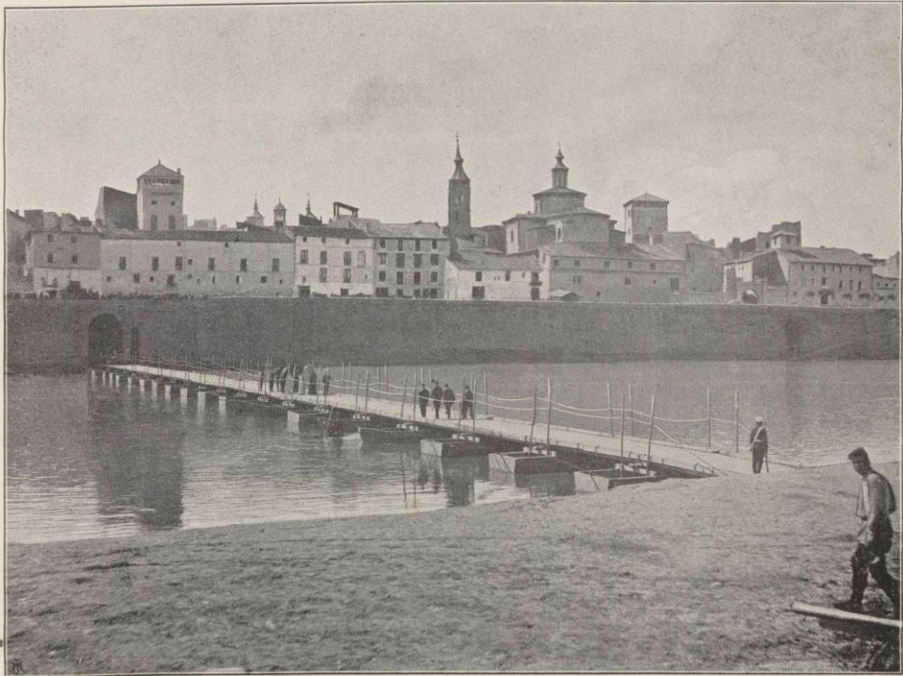
PUENTE POR TROZOS. —Puente construido por trozos y dotado de tramos móviles ó compuertas, á fin de no interrumpir la navegación fluvial, sobre el río Ebro, frente á la ciudad de Zaragoza. Este puente fué construido en dos horas y replegado en una hora.
