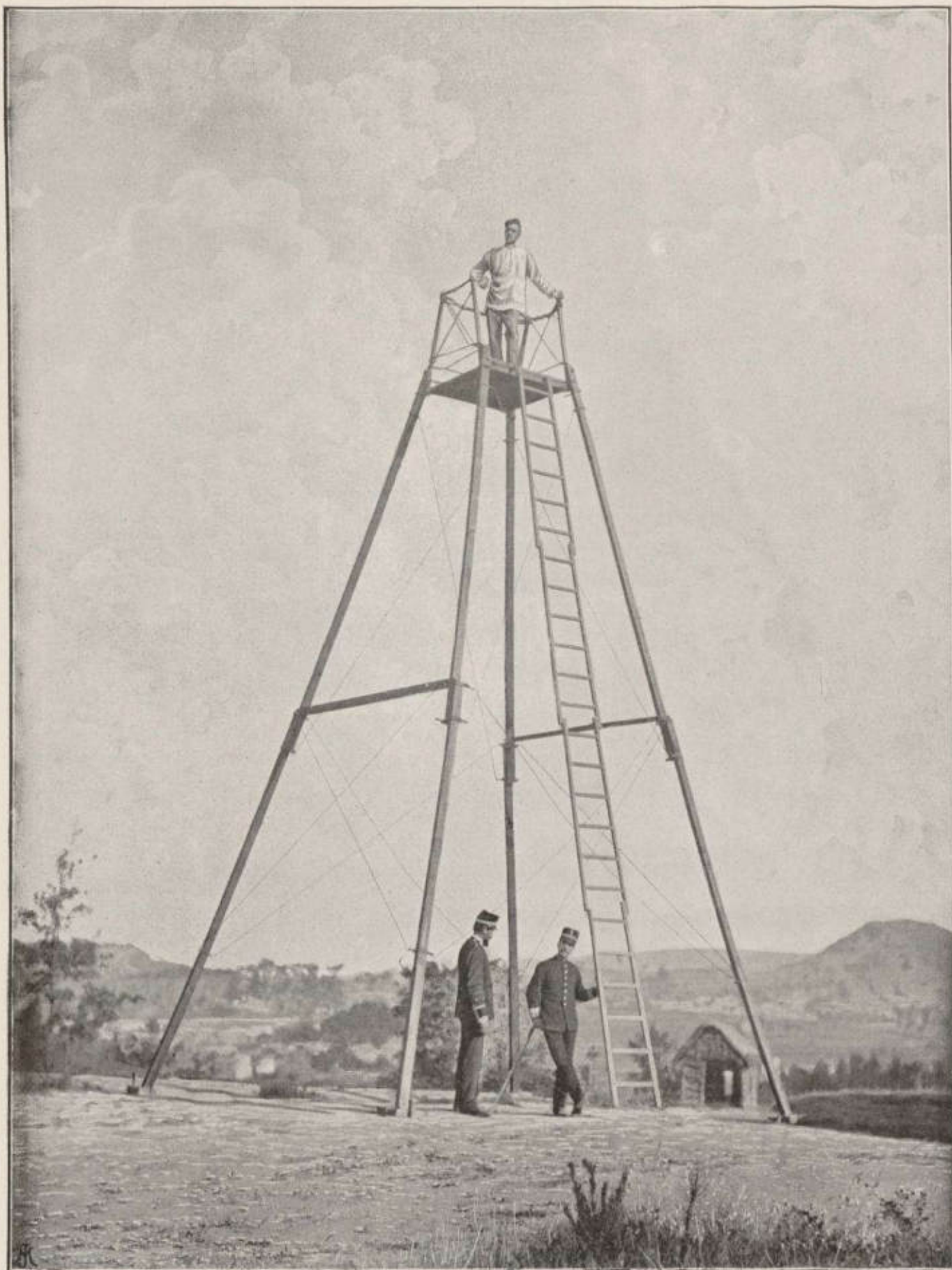
OBSERVATORIO. —No puede imaginarse construcción más simple ni más adecuada que la de esos observatorios desmontables, de tan notoria utilidad al ejército en operaciones, que no hemos podido prescindir de su inclusión en un álbum de las circunstancias del nuestro.
