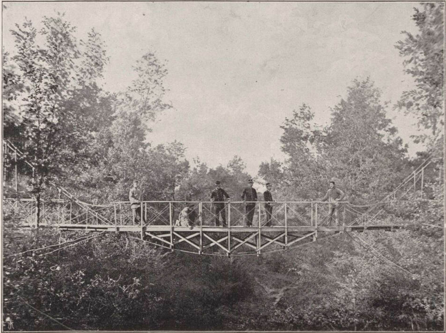
PUENTE MILITAR DE SUSPENSIÓN. —Puente suspendido construido sobre un barranco. El que esta autotipia tan fielmente retrata es uno más dentro la variedad de puentes suspendidos, el cual hasta resulta de cierta elegancia en su construcción.
