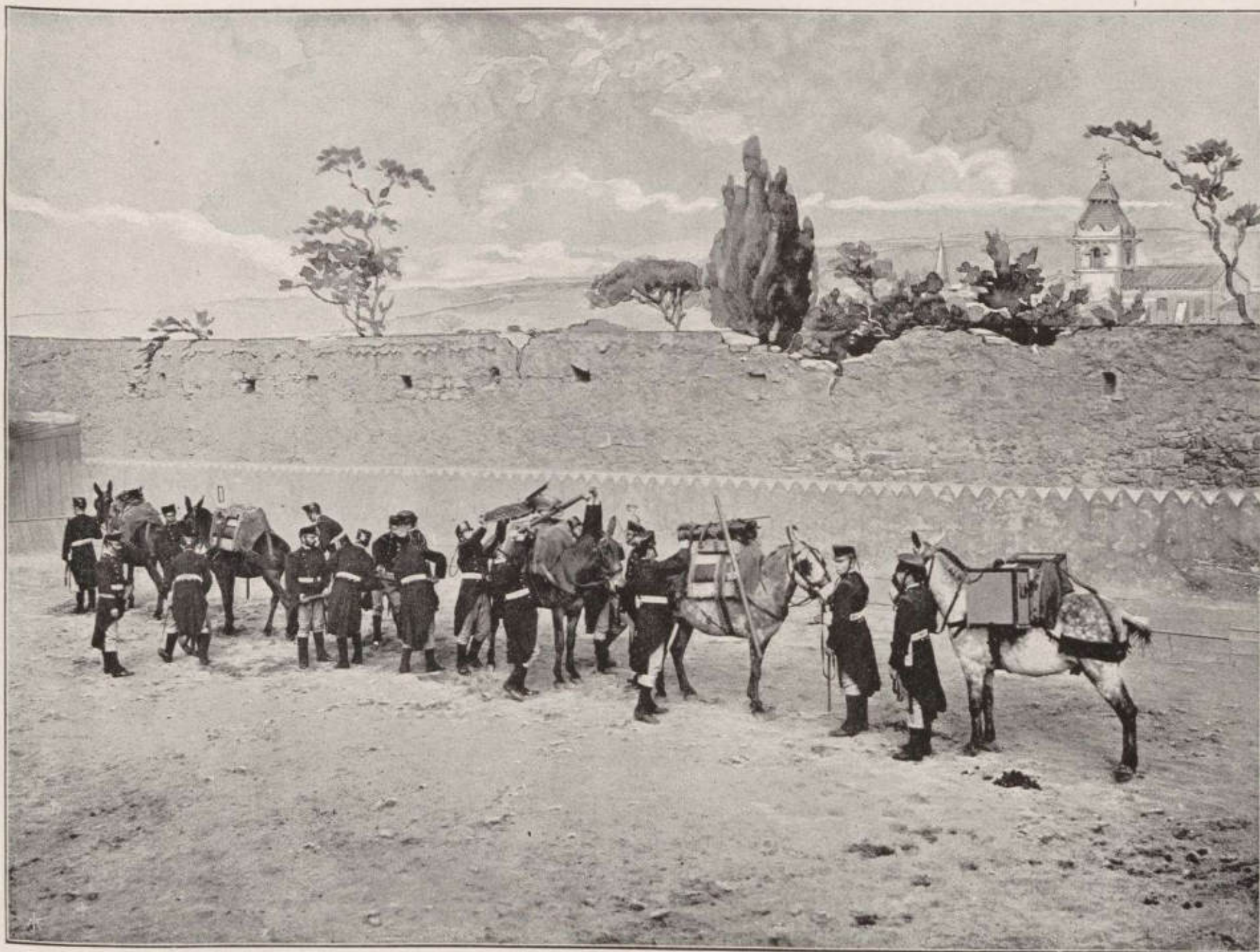
CARGA Á LOMO, DE UNA PIEZA KRUPP. — La nueva pieza que con esta denominación se acaba de ensayar para ser adoptada por nuestra artillería de montaña hace necesaria una acémila más para su conducción que las sistema Plasencia que en la actualidad se usan. Esto es lo que representa este fotografado.
