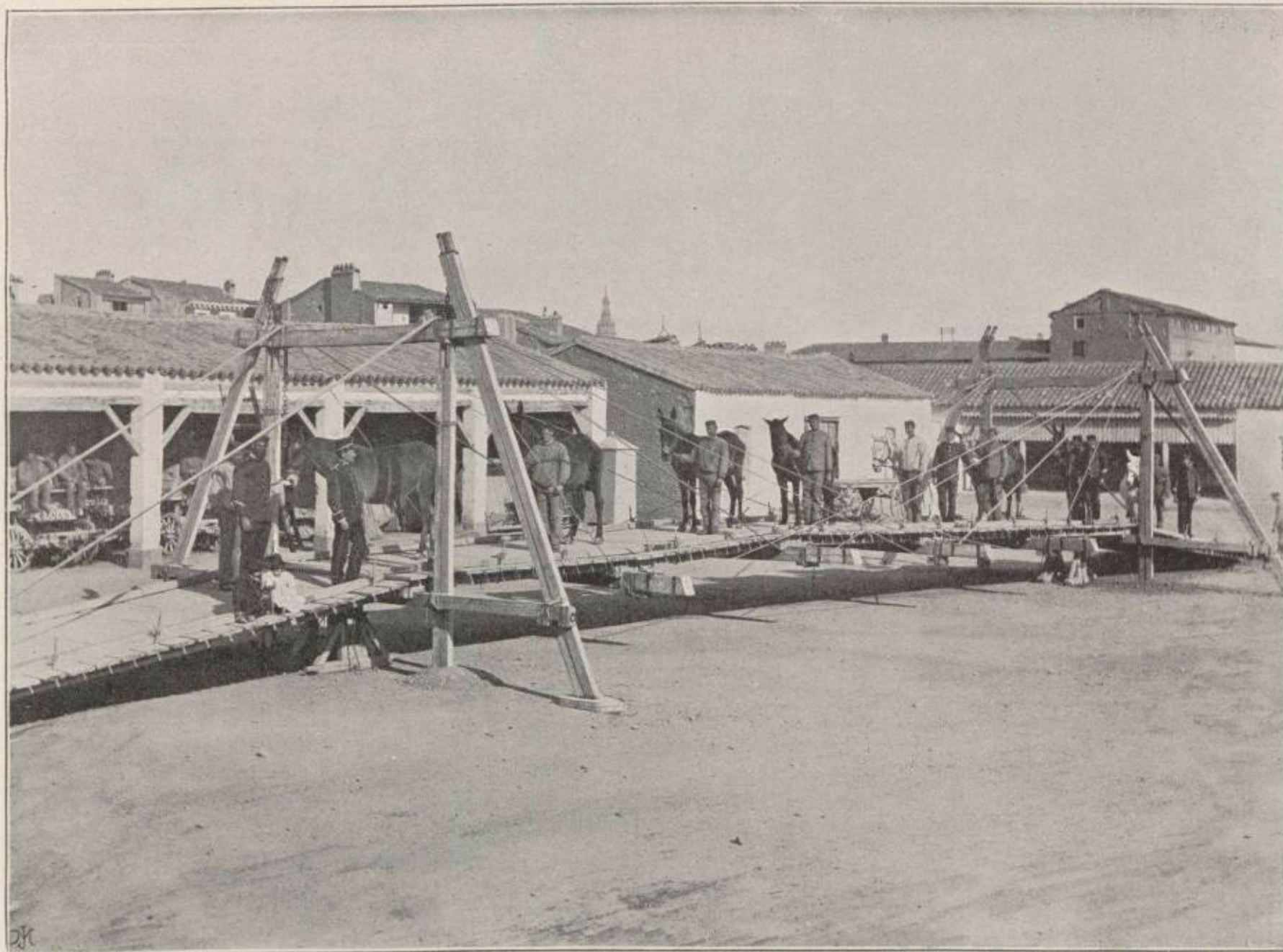
PUENTE DE CIRCUNSTANCIAS. —Á fin de familiarizar el ganado con las oscilaciones que una circulación activa produce en los puentes militares, se le obliga á pasar frecuentemente por ellos, consiguiendo así que los caballos y mulas del regimiento faciliten, en el paso de tropas montadas, el de los animales indóciles ó recelosos.
